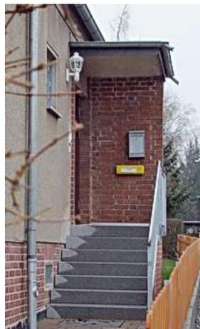
Bei der Sanierung der unteren Außenwände wurden an der Hauseingangstreppe eklatante Baumängel offenbar (fehlende Gründung der Stufen an der Hausmauer), sodass mit der Erneuerung der Treppe nicht vorhersehbare Arbeiten notwendig wurden. Ein neuer Zaun wurde in Eigenleistung montiert.
