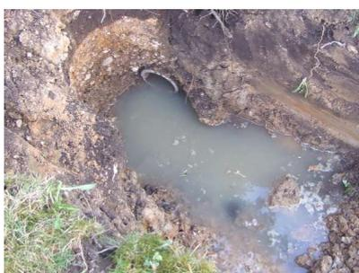
Ein fast gleicher Kamerastandort. Für die Bauarbeiten mußte ein Kanalschacht verlegt werden. Beim Ausschachten stellte sich heraus, dass die Abwässer aus der Nachbarschaft durch defekte Rohre auf unserem Grundstück unterhalb des Rasens versickerten. Der Geruch war mitunter bis in den Gemeinderaum wahrnehmbar.
